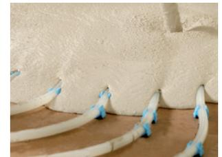
Fußbodenheizungsrohre müssen gegen Aufschwimmen gesichert sein.
