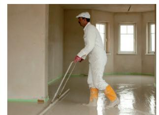
Großflächig eingebracht wird der Fließestrich durch leichtes Rakeln.
