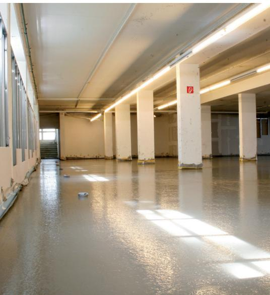
Aaton® wird standardmäßig als C25/30 mit einer fließfähigen Konsistenz ECC und Größtkorn 16 mm ausgeliefert. Laut ÖBV-Richtlinie „Selbst- und Leichtverdichtbarer Beton“ entspricht er so der Type eines „Easy Compacting Concrete“ (ECC). Um jedoch für verschiedene Anwendungen die passende Betonzusammensetzung zur Verfügung stellen zu können, bieten wir Aaton® in unterschiedlichen Expositionsklassen an:
