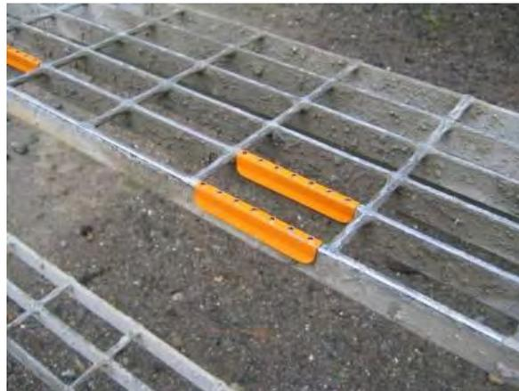
Abbildung 10: Rutschhemmende Klammern bei der Stufen-Auftrittsfläche
