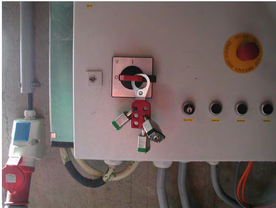
Abbildung 27: Hauptschalter gesichert mit Vorhängeschlossperre
