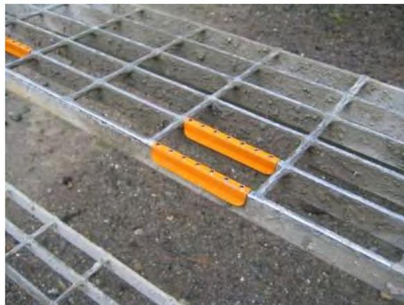
Abbildung 18: Rutschhemmende Klammern bei der Stufen-Auftrittsfläche
